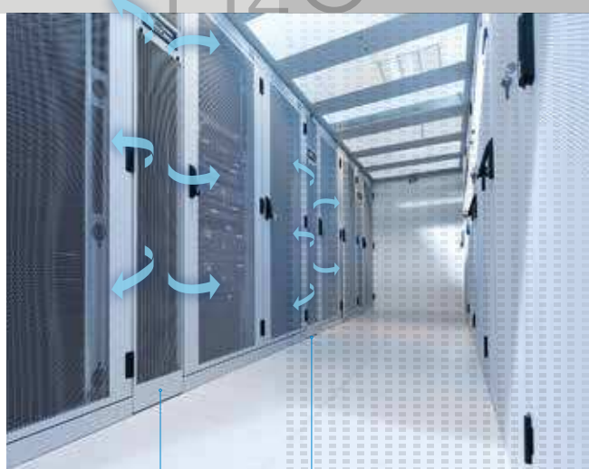
Vizes rendszer hideg levegő áramlása
