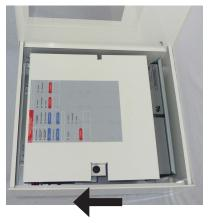
Déplacer le capot pour désolidariser le capot du socle.
