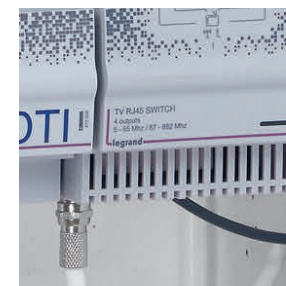
RÉPARTITEUR TV DU COFFRET FULL MEDIA TOUT RJ 45 POUR LOGEMENT T4, T5, T6 (RÉF. 0 930 79)
