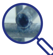
Noircissement sur l'extrémité du fil
