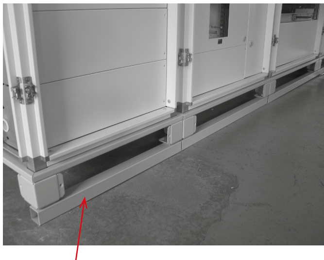
Fig. 1 - Renforts sur tableaux XL³ 4000
