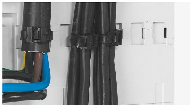
Il est possible ensuite d'arrimer les câbles sur le fond du coffret avec des colliers de serrage Colson ou Colring.
