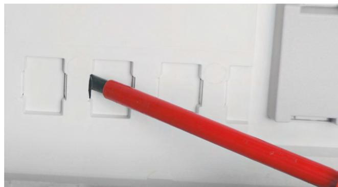
Le passage des câbles est pré-découpé, il suffit de défoncer les passages.
