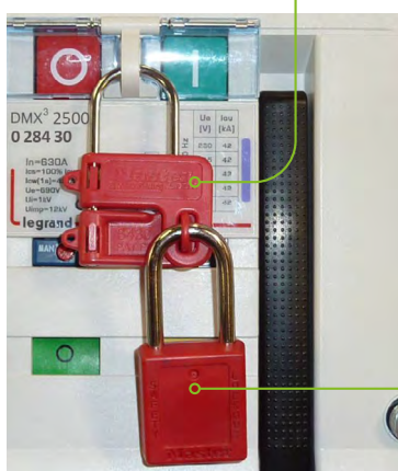
Cadenassage des boutons ON et OFF
