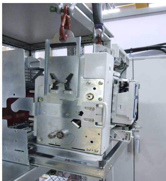
Mise en place d'un DMX 3 débrochable dans sa base
