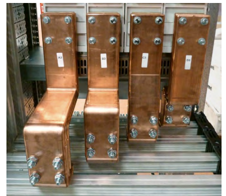
Kit liaison entre DMX 3 taille 2500 fixe et jeu de barre de transfert en aluminium
