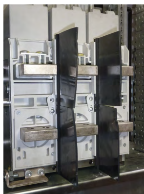
Exemple : cloisons de séparation montées sur un DMX 3 3P fixe
