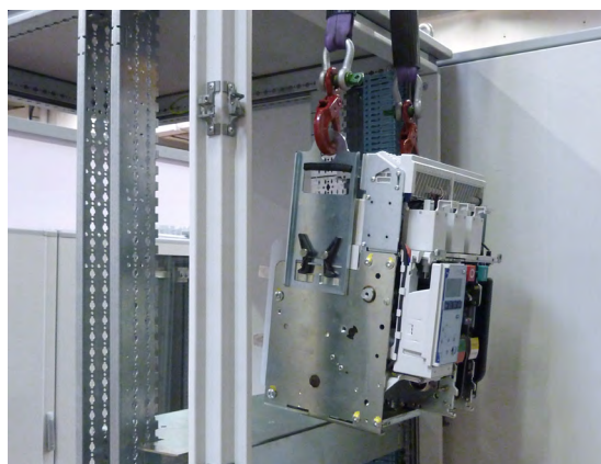
Mise en place d'un DMX 3 fixe
