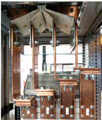
Kit de liaison entre DMX 3 taille 2500 débrochable et une arrivée SCP
