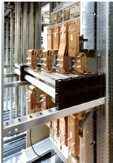
Kit de liaison entre inverseur DMX 3 taille 2500 débrochable et un jeu de barres de transfert en aluminium
