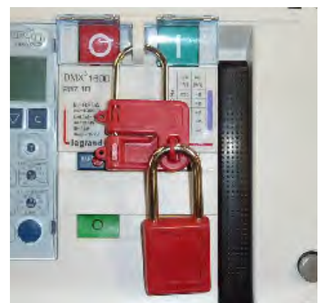
Cadenassage des boutons ON et OFF
