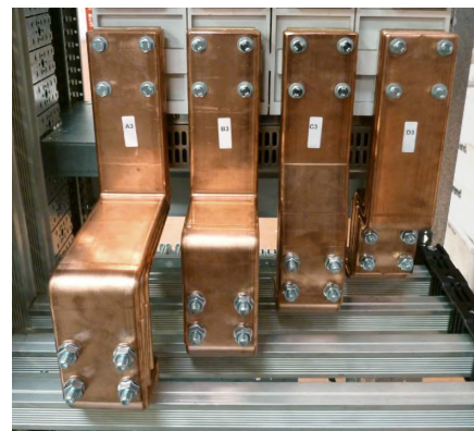
Kit liaison entre DMX 3 taille 2500 fixe et jeu de barre de transfert en aluminium
