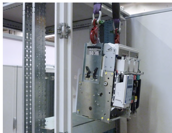
Mise en place d'un DMX 3 fixe
