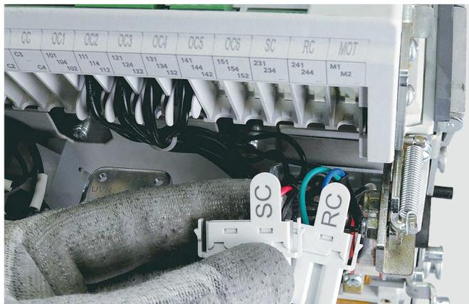
Remettre en place le cache plastique du bornier, puis la face avant à l'aide des 4 vis (embout empreinte Phillips n° 1, couple de serrage de 1 Nm), puis les cache-vis.
