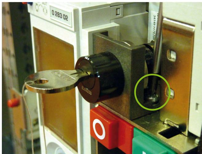
Positionner l'ensemble au-dessus du bouton « OFF » du DMX-SP dans l'encoche prévue.
