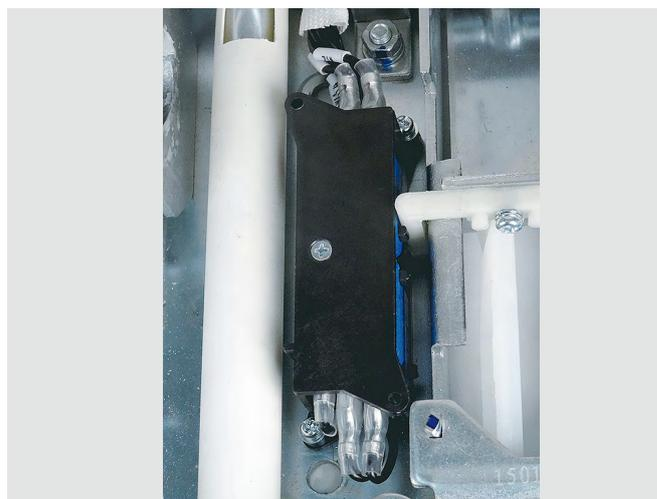
Réembrocher le DMX-SP et effectuer un essai de fonctionnement mécanique et électrique en essayant toutes les positions (embroché-test-débroché).
