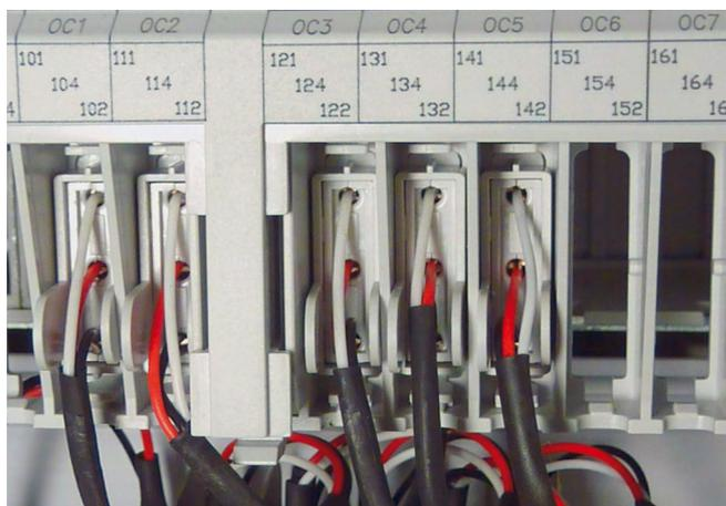
Quatre contacts auxiliaires pré-installés et un contact auxiliaire optionnel.
