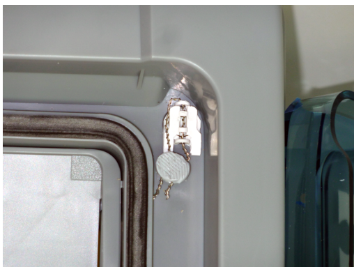
Plombage des vis de la face avant.
