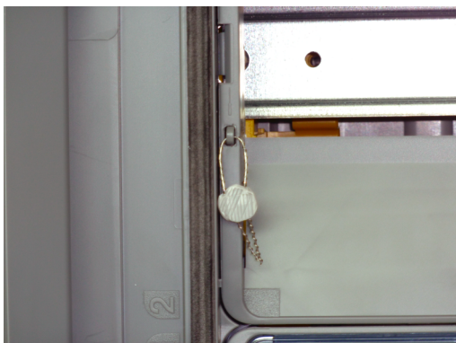
Plombage des plastrons.
