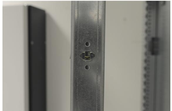
2. Assembler un bandeau vertical avec un bandeau horizontal en veillant à insérer correctement l'ergot dans la fente.
