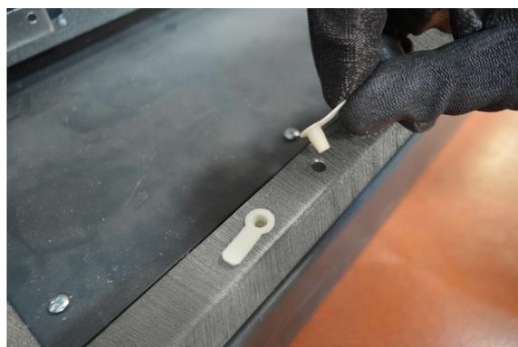
3. Mettre en place les clips-écrou sur les 2 pattes avec les trous carrés puis fixer celles-ci à la structure de l'enveloppe: vis tête fraisée → empreinte Phillips n° 2, couple de serrage 5 Nm.
