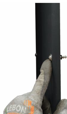
4. Accrocher le panneau sur la patte de maintien et fixer celui-ci en tournant les vis d'1/4 de tour vers la droite.
