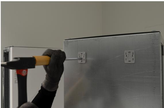
2. Positionner l'enveloppe et marquer l'emplacement des chevilles si nécessaire (cloison ou mur porteur dur style parpaing, brique, etc.).
