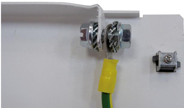
5. Prendre la vis auto-taraudeuse avec une rondelle plate et fixer l'autre extrémité du câble sur le montant arrière de structure de l'enveloppe.
