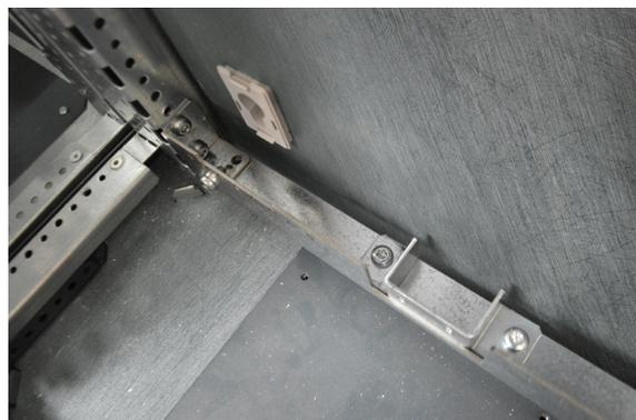
1. Insérer le montant de la gaine à câble interne dans les 2 pattes-support et fixer celui-ci à l'aide des 4 vis → clé Torx T30, couple de serrage 5 Nm.
