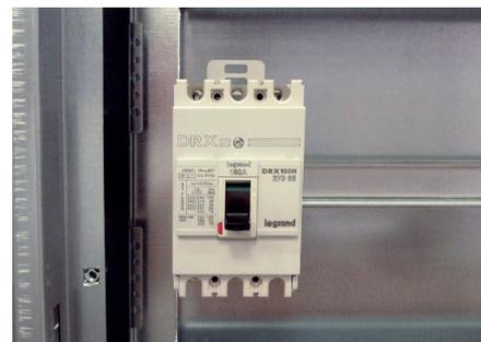
Il est possible de monter des appareils modulaires (MCB) à côté d'un DRX. Pour cela, il faut utiliser la rehausse de rail réf. 3 382 41. Après l'avoir coupé en longueur (si besoin), il faut la clipser sur le rail oméga à côté du DRX.
