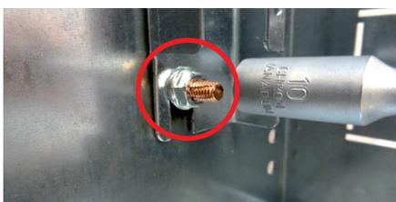
Pour remettre le châssis, il faut l'insérer sur les 2 plots du bas puis sur les 2 plots du haut. Visser les 4 écrous en commençant par les 2 du haut :
