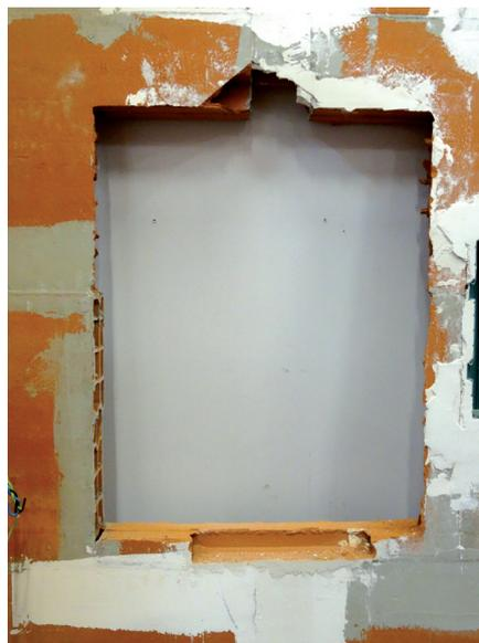
Mettre en place le coffret dans le trou et insérer l'ensemble des gaines :
