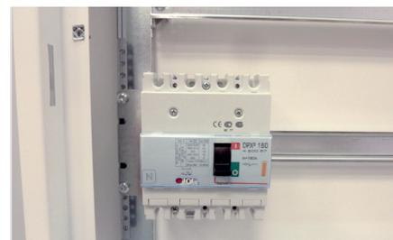
Il est possible de monter des appareils modulaires (MCB) à côté d'un DPX<sup>3</sup> 160. Pour cela, il faut utiliser la rehausse de rail réf. 3 382 40. Après l'avoir coupé en longueur (si besoin), il faut la clipser sur le rail oméga à côté du DPX<sup>3</sup>.
