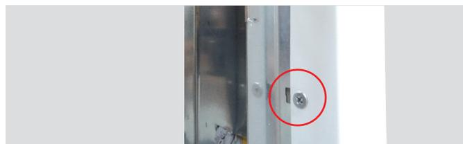
4- Toujours suivant la profondeur d'encastrement, il sera nécessaire de clipser le ou les caches (suivant le nombre de poignées sur la porte) plastiques fournis à l'opposé de la (ou des) serrure(s) → côté charnières
