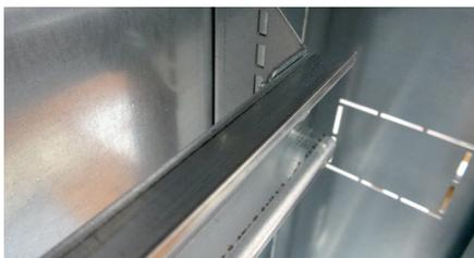
La fonction extractible du châssis permet de régler les rails et d'installer les produits en dehors du coffret, sur un établi ou autre. Le câblage peut ainsi être réalisé en atelier, en parallèle de l'installation du coffret sur le chantier.
