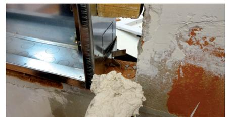
Sur le flanc du coffret, deux repères indiquent la profondeur maxi et mini d'encastrement ( finition comprise ) :
