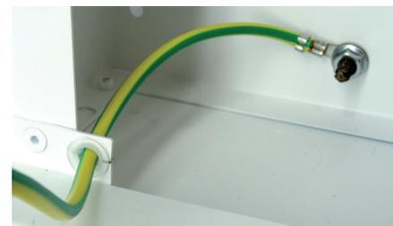
3- Retirer le cache de protection du plot de terre de la porte puis fixer la 2<sup>ème</sup> extrémité du câble à l'aide d'un écrou M6.
