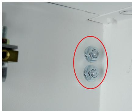
2- Fixer le coffret au mur à l'aide de 4 vis Ø 6 mm minimum.
