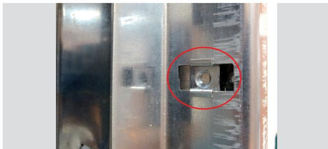
2- Suivant la profondeur d'encastrement du coffret il sera nécessaire de retirer la pré-découpe sur le cadre pour permettre le passage du loquet de la poignée.
