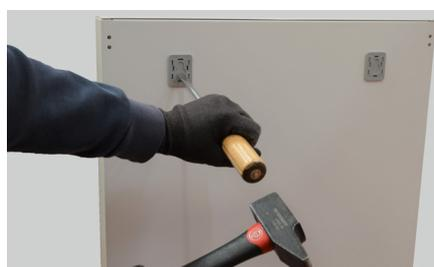
2- Fixer le coffret à l'aide de 4 vis (Ø 6 mm minimum) et 4 rondelles.
