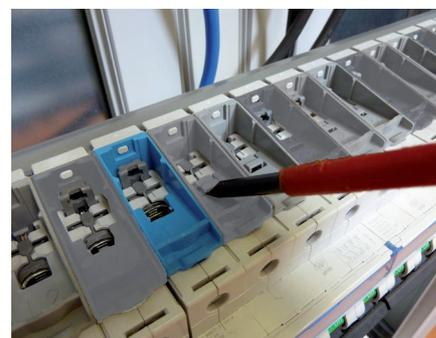
Pour alimenter directement le répartiteur par les bornes d'un des appareils, casser préalablement les languettes de protection sur les modules de connexion.
