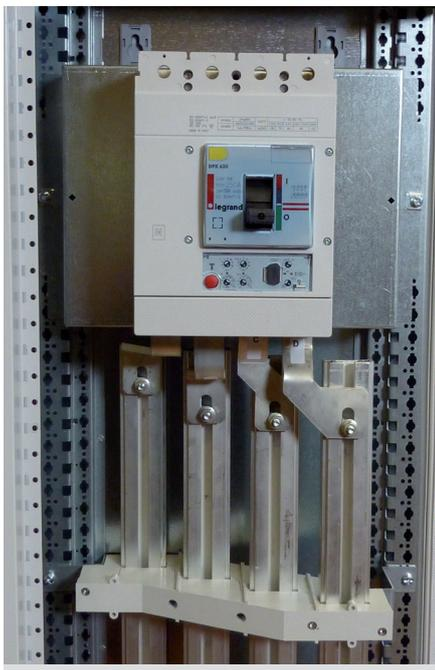
Le principe est le même que pour la répartition en fond d'armoire (voir p. 27). L'appareil est fixé sur sa platine et monté dans la gaine à câble. Ensuite, utiliser les kits de raccordement préfabriqués dédiés pour le raccorder au jeu de barres.
