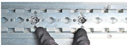
Pour fixer le montant fonctionnel sur les traverses en fond d'enveloppe, insérer quatre clips-écrous dans les trous repérés.
