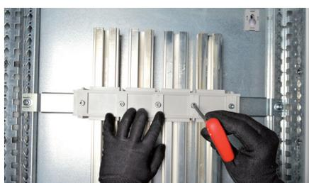
Visser la partie avant des supports pour immobiliser les barres. Ne pas oublier de serrer définitivement les vis du support talon.
