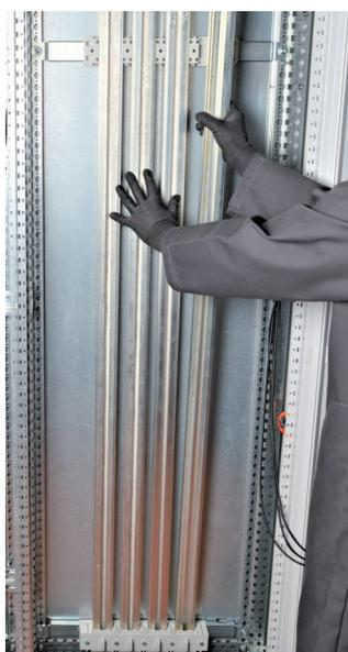
Positionner les barres alu en C en prenant appui sur le support talon.
