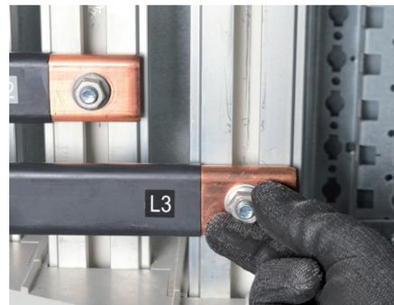
Les barres étant déjà percées, vous n'avez plus qu'à raccorder l'appareil de tête au jeu de barre par l'intermédiaire d'écrous marteaux.
