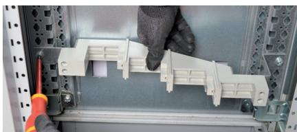
Fixer le support talon réf. 4 044 51 (XL<sup>3</sup> 400) ou réf. 4 044 71 (XL<sup>3</sup> 800) sur la partie basse des montants de la gaine à câbles à l'aide des clips-écrous et de vis M6.
