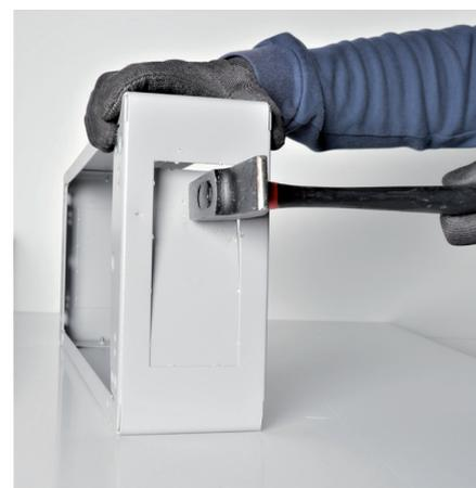
L'ouverture est réalisée à l'aide d'un marteau.
