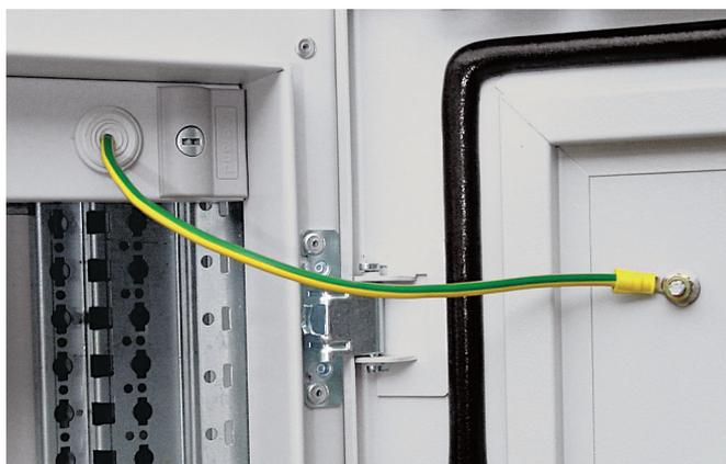
Faire pénétrer les conducteurs dans l'enveloppe par un plastron plein équipé d'un embout réf. 0 919 14 (perçage Ø 23 mm).
