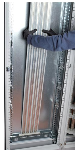
Positionnez le fond isolant réf. 4 044 36 et les barres alu en C.
