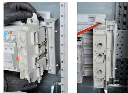
Positionner et verrouiller le module d'alimentation latérale du répartiteur (réf. 4 044 82) du côté de la gaine à câbles où se trouve le jeu de barres.
