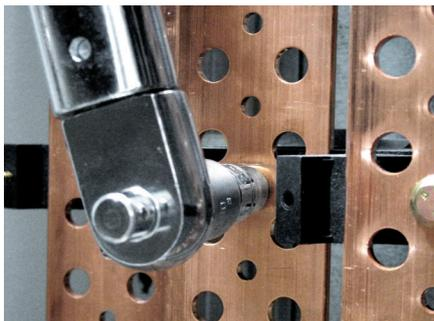
Fixer les barres sur les supports (serrage 7 Nm).
