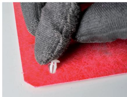
Après avoir fixé les 2 platines aux montants fonctionnels de l'armoire, il faut installer la plaque isolante à l'aide des clips isolants fournis.
