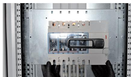
Mettre en place l'appareil de tête sur sa platine.
