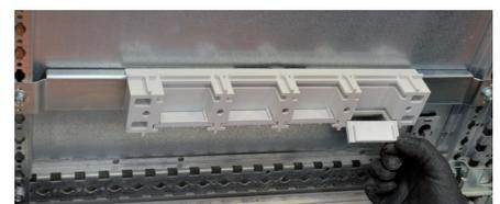
Fixer le support talon réf. 4 044 61 en bas de l'armoire et insérer les cales où viendront s'appuyer les barres.
