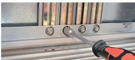
Les RDR sont pré-équipés d'écrous marteaux. Serrez ceux-ci afin d'assurer la connexion avec le jeu de barres. (Couple de serrage : 20 Nm)
