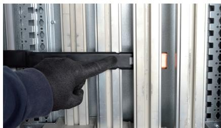
En fonction du positionnement de la gaine à câble (droite ou gauche), il sera nécessaire de recouper certaines barres du kit afin de les connecter correctement. Pour ce faire, prépositionner les barres afin de visualiser la marque indiquant l'endroit de découpe.
