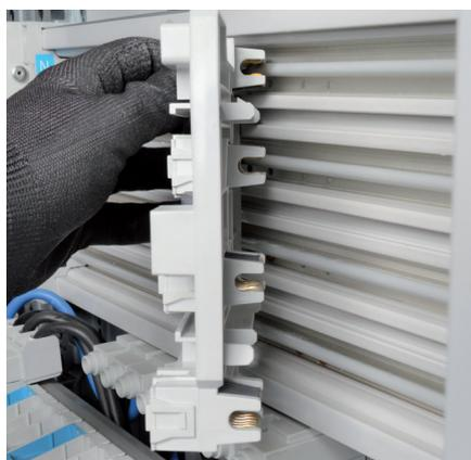
Mettre en place la partie fixe de la base support sur le répartiteur de rangée.
