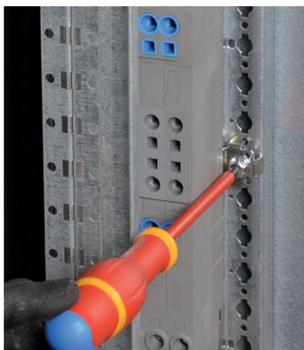
Fixer l'ensemble sur les montants de l'armoire à l'aide des écrous clips préalablement montés.
