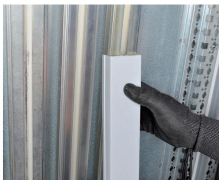
Le degré de protection IPXXB est obtenu en installant les profil isolants réf. 4 044 62 sur barres alu en C.
