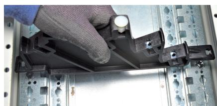
Fixer les supports de jeu de barres sur les montants fonctionnels de la gaine à câbles à l'aide des clips-écrous et vis M6 fournis. Insérer les clips-écrous sur le profil haut des montants.
