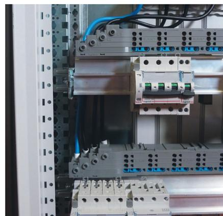
Serrer les bornes de ce premier répartiteur puis raccorder le second (serrage 3 Nm).
