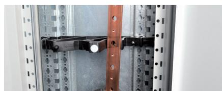
Positionner les barres de cuivre sur les supports.
