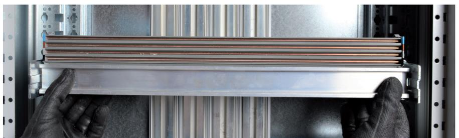
Positionner le rail dans l'enveloppe en position haute ou basse.
