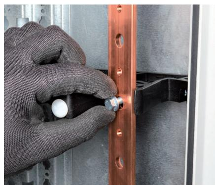
Fixer les barres de cuivre sur les supports à l'aide de vis M6 à tête hexagonale à rondelle intégrée.
