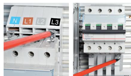
Le disjoncteur est correctement installé une fois le verrouillage des griffes effectué.
