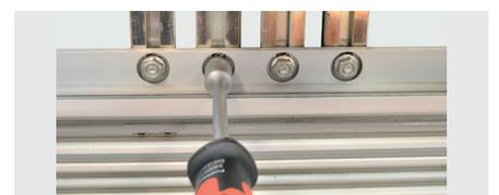
Les répartiteurs de rangée sont pré-équipés d'écrous marteaux. Serrez ceux-ci afin d'assurer la connexion avec le jeu de barres (couple de serrage : 20 Nm).
