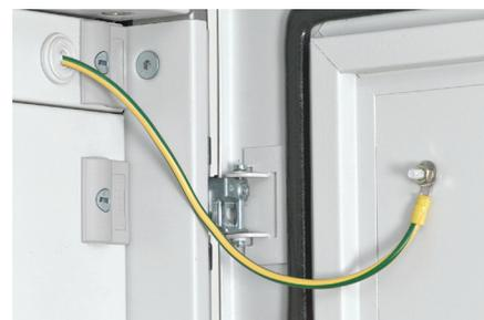
Pour le passage des conducteurs, utiliser un plastron plein équipé d'un embout Plexo réf. 0 919 14 (perçage Ø 23 mm) voir également page 17.
