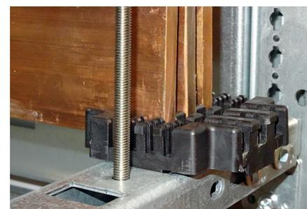
Afin d'éviter le contact entre la barre et le flanc, positionner la barre au milieu du dernier support.
