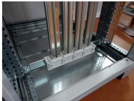
Fixer le support talon réf. 4 044 60 entre les montants fonctionnels et positionner les barres
