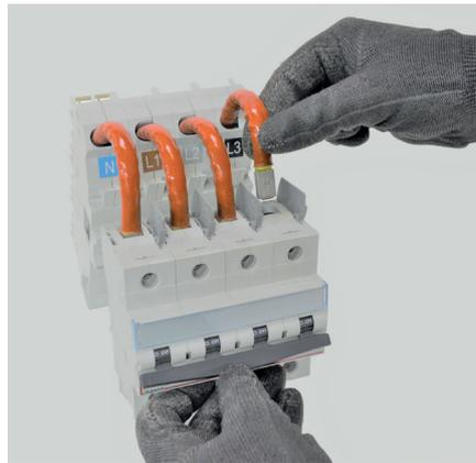
Raccorder les fils dans le disjoncteur sans l'installer sur la partie "rail" de la base support.
