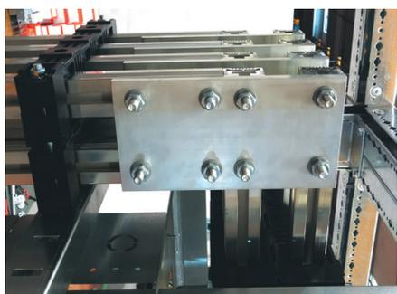
Les entraxes entre barres étant les mêmes (75 mm pour supports réf. 0 373 22 et 0 373 66, 125 mm pour supports réf. 0 373 24 et 0 373 68), les raccordements sont réalisés très facilement à l'aide des plaques de connexion simples (réf. 0 373 82) ou doubles (réf. 0 373 83).
