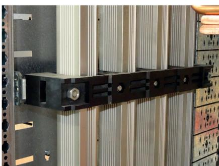
Positionner les barres et serrer les supports afin d'assurer le maintien des barres. (Couple de serrage voir page 29)
