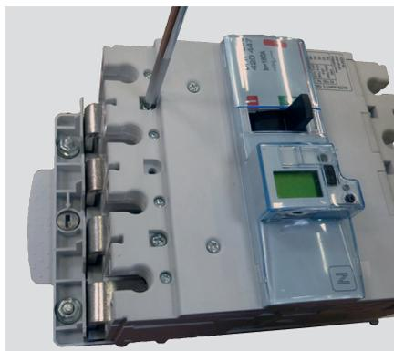
Solidariser l'appareil et la base à l'aide des vis de fixation fournies avec la base.
