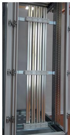
Vérifier le bon serrage des barres en revisant les vis des supports.
