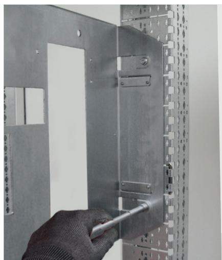
Verrouillage de la platine par vis et clips-écrous M6
