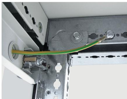
D'un côté le cordon se fixe sur la structure de l'armoire à l'aide d'un clips écrou et d'une vis M6.
