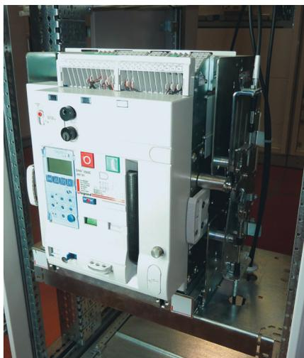
Dans le cas de DMX<sup>3</sup> dans la même armoire (inverseur de source par exemple), il est nécessaire de laisser un espace de 200 mm entre les 2 plastrons. Cette espace correspond à la hauteur nécessaire pour le passage du jeu de barres transfert.
