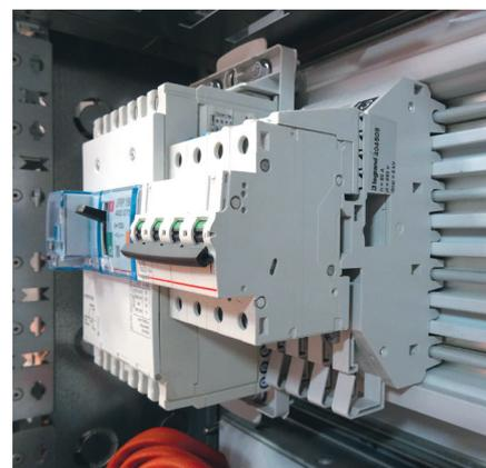
Clipser ensuite le disjoncteur sur la base par simple pression, puis verrouiller à l'aide des griffes.
