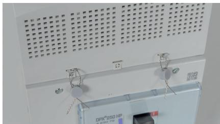
Des petites plaquettes sécables sont à insérer ou à enlever sur les cache bornes suivant les configurations de câblage.
