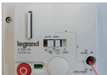
Orifice pour ouverture/fermeture manuelle
