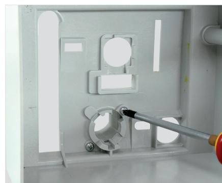
5. Insérer le barillet et le fixer à l'aide de l'écrou fourni (couple de serrage 2 N.m).
