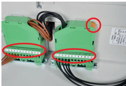
Les différentes sections de câble ainsi que les préconisations d'emplacement des fils sont indiquées sur la notice suivant les accessoires présents.
