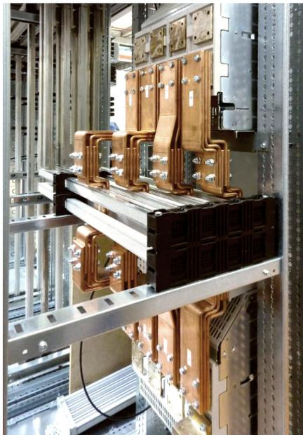
Kit de liaison entre inverseur DMX<sup>3</sup> taille 2500 débrochable et un jeu de barres de transfert en aluminium
