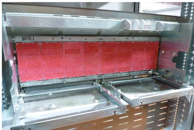
Base vide pour DMX<sup>3</sup> - taille 6300 - 4 pôles - réf. 0 289 14 et le bornier réf. 0 290 12 (pièce détachée)
