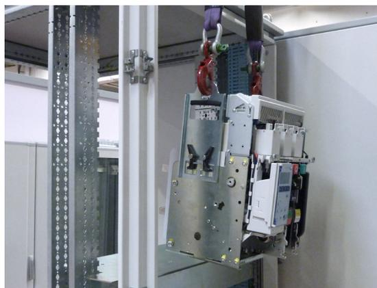
Mise en place d'un DMX<sup>3</sup> fixe
