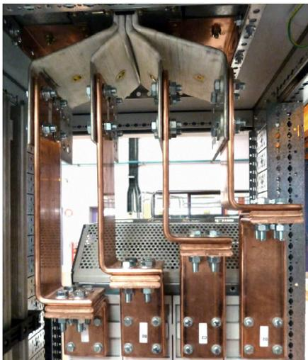
Kit de liaison entre DMX<sup>3</sup> taille 2500 débrochable et une arrivée SCP
