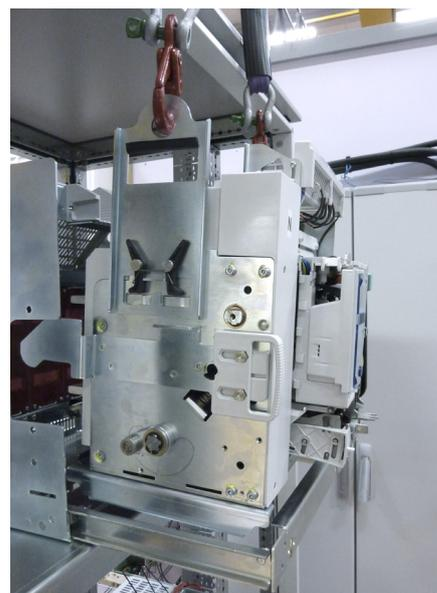
Mise en place d'un DMX<sup>3</sup> débrochable dans sa base
