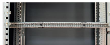
Il est également possible de fixer la goulotte directement sur les montants arrière en utilisant les rivets isolants réf. 0 200 80.
