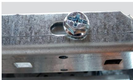
**i** Pour la réalisation d'un jeu de barres aluminium en C jusqu'à 3200 A, le support volant réf. 3 399 27 est utilisé pour doubler les supports fixes réfs. 3 399 25/26 à l'aide du kit pour supports jeu de barres réf. 3 399 24 (idem photo page 75).
