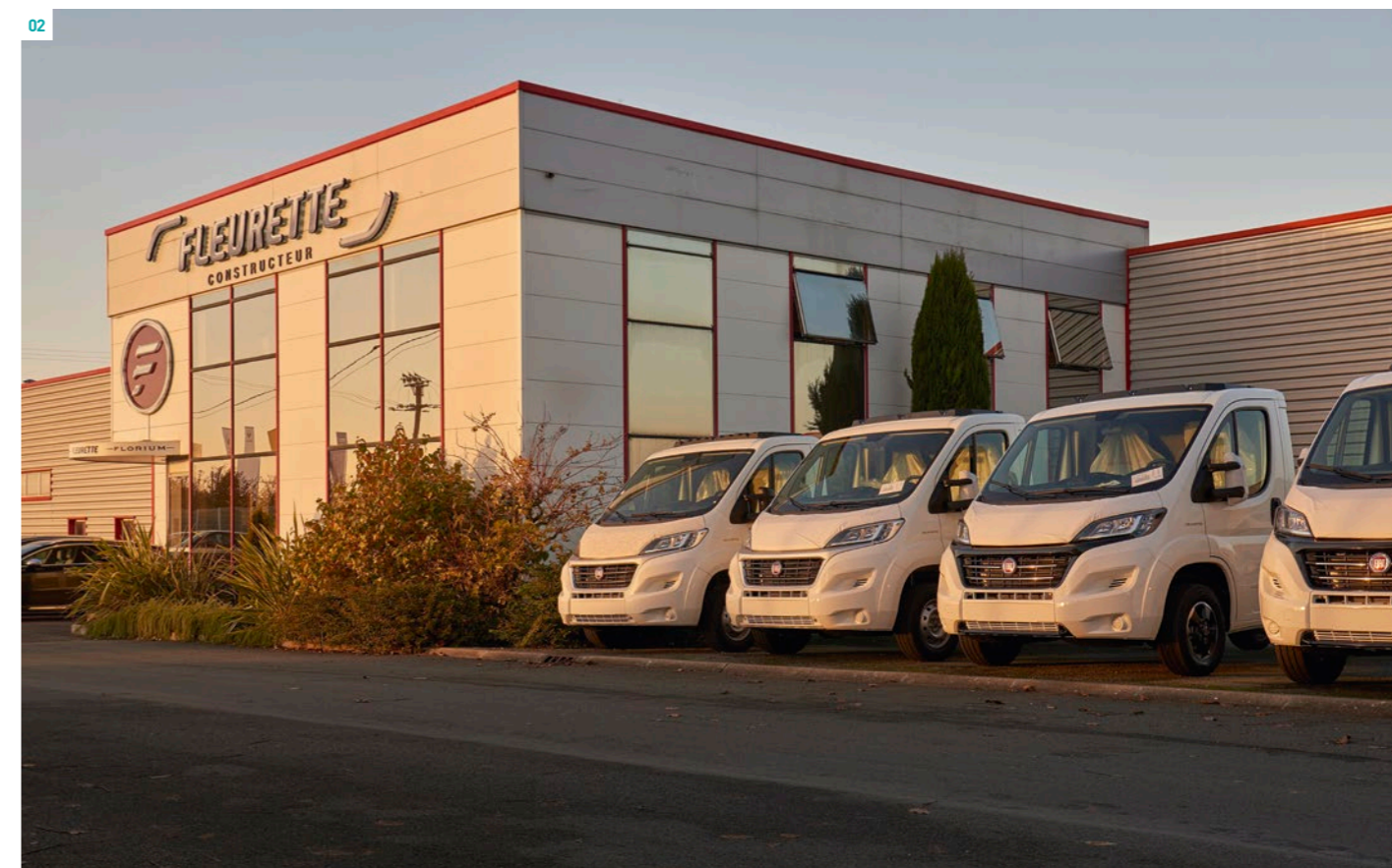
01_ Que ce soit pour des constructeurs haut de gamme ou bien même plus généralistes, les cahiers des charges sont de plus en plus stricts. La demande porte sur des packages complets de matériels. 02_ Dans les sites de production, les constructeurs sont attentifs à la fiabilité du matériel mais aussi à la maîtrise des consommations.
