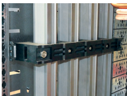
Positionner les barres et serrer les supports afin d'assurer le maintien des barres. (Couple de serrage voir page 27)
