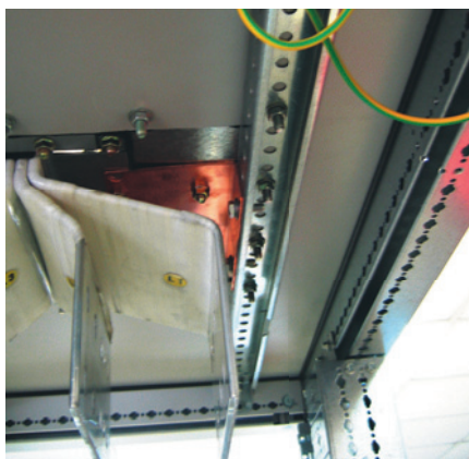
Le dispositif de liaison se fixe sur les traverses de renfort à travers le toit
