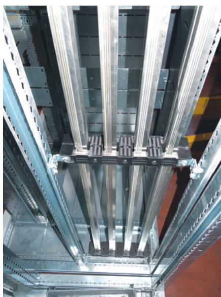
Positionner les barres et serrer les supports afin d'assurer le maintien des barres. (Couple de serrage voir page 27)
