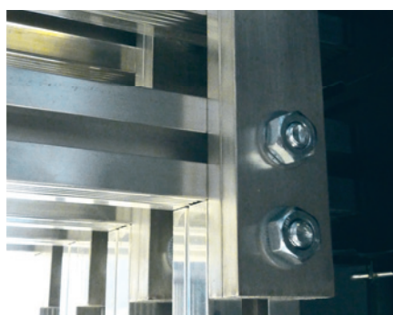
Raccordement d'un jeu de barres aluminium sur un jeu de barres principal double réalisé en barres aluminium
