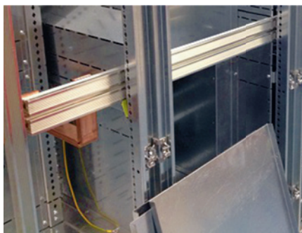
Borne principale constituée d'une barre cuivre ou barre aluminium.
