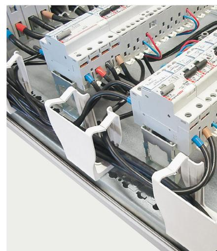
Exemple de circulation de filerie réalisée par bracelets
