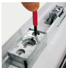
Desserrer les deux vis de fixation de la poignée et du mécanisme.
