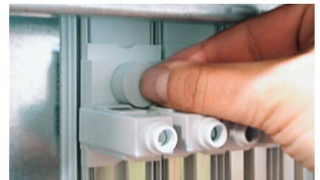
Cette borne permet le raccordement de 2 conducteurs et assure une protection IP XXB avec bouchon cache-vis inséré.
