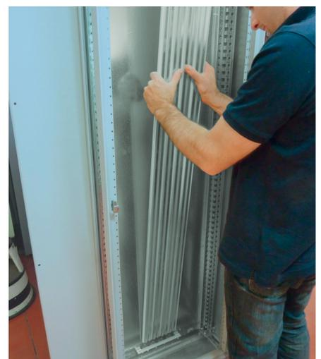
Positionnez le fond isolant réf. 4 044 36 et les barres alu en C.
