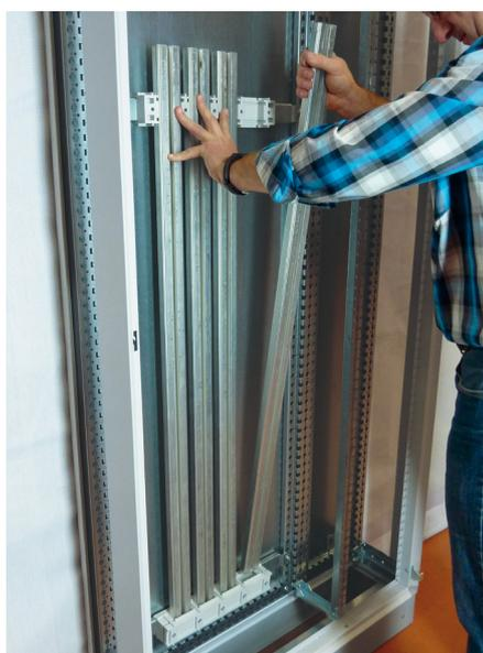
Positionner les barres alu en C en prenant appui sur le support talon.
