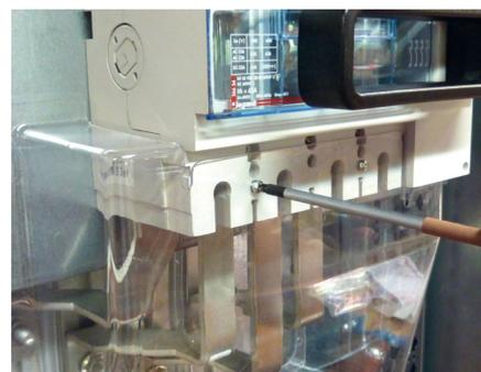
Mettre en place le capot de protection IP XXB livré avec le kit.
