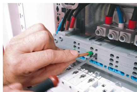
**!** Attention la connexion et la déconnexion ne doivent pas être faites sous tension. Il est impératif de couper l'alimentation des répartiteurs avant toute intervention.
