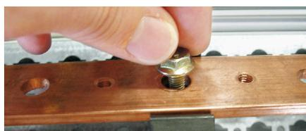
Fixer les barres de cuivre sur les supports à l'aide de vis M6 à tête hexagonale à rondelle intégrée.
