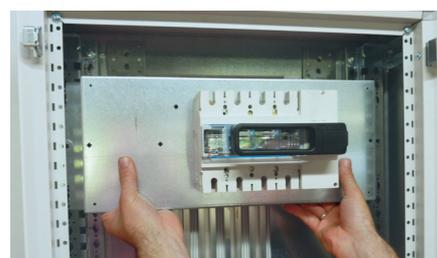
Mettre en place l'appareil de tête sur sa platine.
