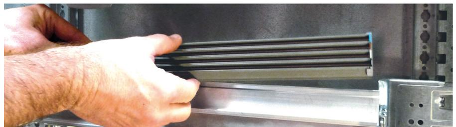
Le répartiteur HX<sup>3</sup> plug se monte directement sur les rails réf. 0 202 06 et 0 206 01/51 par simple clipsage.
