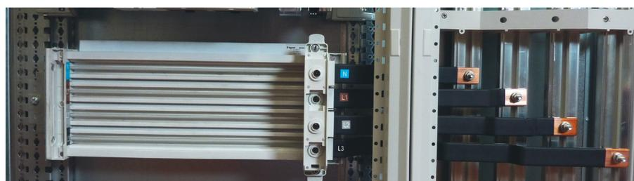
Raccorder ensuite le module d'alimentation au jeu de barre par l'intermédiaire du kit de raccordement préfabriqué.
