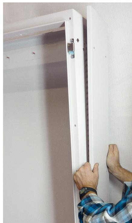
Les flancs sont livrés par deux avec leur joint d'étanchéité posé, les vis de fixation et des obturateurs plastique.
