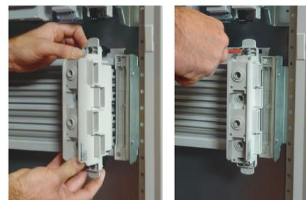
Positionner et verrouiller le module d'alimentation latérale du répartiteur (réf. 4 044 82) du côté de la gaine à câbles où se trouve le jeu de barres.
