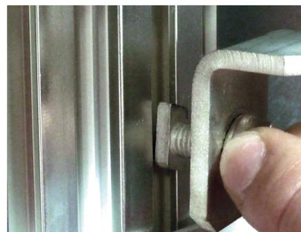
La connexion des kits sur le jeu de barres est réalisée par les écrous marteaux livrés avec les kits.
