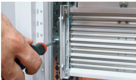
Positionner et fixer le RDR sur les montants fonctionnels de l'armoire.
