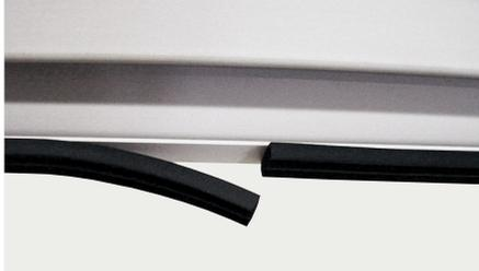
Le raccordement du joint doit être réalisé dans la partie basse de la porte.
