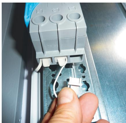
Afin de respecter la protection IP XXB, il est impératif de mettre en place les bouchons de protection sur les bornes d'alimentation non utilisées. Ces bornes seront utilisées dans le cas d'une alimentation d'un répartiteur à l'autre.
