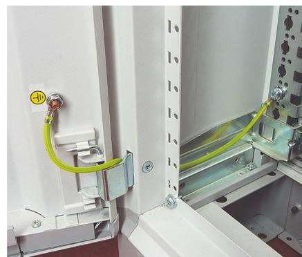
Le conducteur réf. 0 373 85 est muni d'une "cosse à œil" à chacune de ses extrémités. Faire passer le conducteur derrière la charnière pour ne pas gêner le plastronnage.
