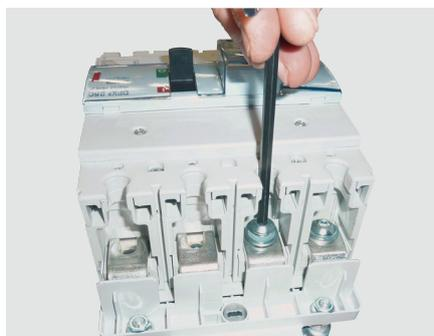
Réaliser les connexions électriques amont avec les vis fournies avec le disjoncteur (clé 6 pans de 4, couple de serrage de 7 Nm).
