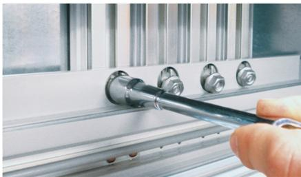
Les RDR sont pré-équipés d'écrous mar-teaux. Serrez ceux-ci afin d'assurer la connexion avec le jeu de barre.
