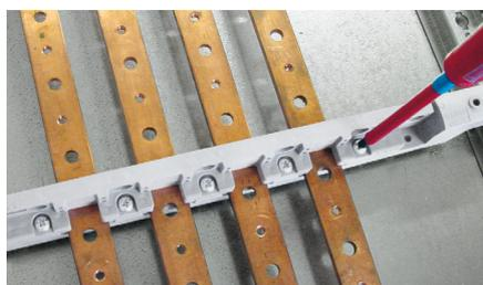
Une fois la bonne position déterminée, fixer la traverse de maintien sur le support avec les 5 vis à tête cylindrique. Ne pas bloquer ces vis car la position des barres pourra être ajustée ultérieurement.
