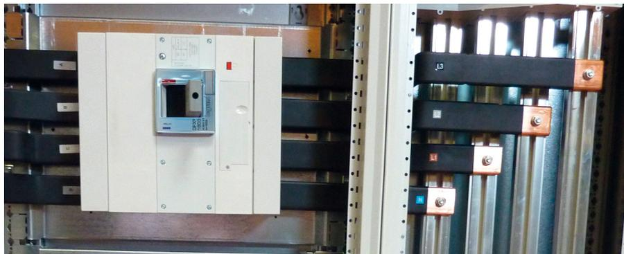
Dans ce type de montage, l'appareil de tête sera placé horizontalement dans l'armoire et sera connecté au jeu de barre par le biais du kit préfabriqué dédié. Une fois l'appareil de tête monté dans l'armoire, raccorder les différentes barres du kit de raccordement au jeu de barre.
