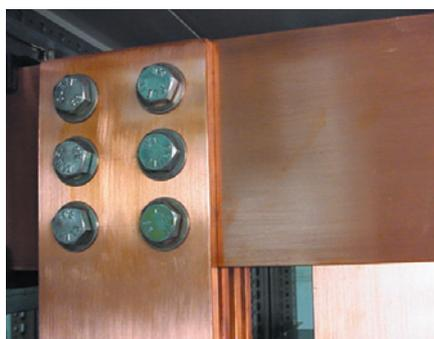
Raccordement sur barres 120 x 10 (4000 A)
