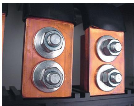
Raccordement d'une barre 50 x 10 par 2 vis M12 réf. 0 374 65 avec rondelles larges intégrées
