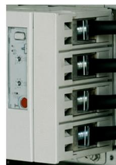
Raccordement direct d'un DPX<sup>3</sup> 630 par bornes à cage réf. 0 262 50
