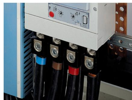
Raccordement de deux conducteurs aluminium de 185 mm<sup>2</sup> par pôle sur d'un DPX<sup>3</sup> 630 avec les bornes réf. 0 261 51
