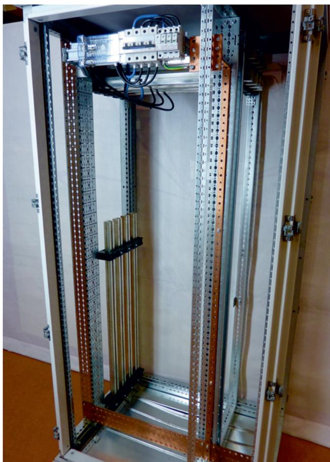
Exemple de réalisation dans une armoire XL<sup>3</sup> avec l'alimentation par le bas de la protection associée au parafoudre.
