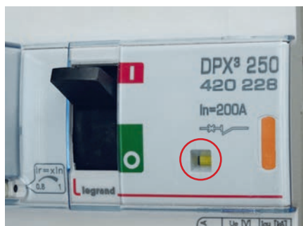
Déclenché (sur défaut différentiel)
