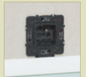
Fixation du support Batibox et du mécanisme Céliane
