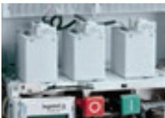
**Auxiliaires** de commande et de signalisation, à clipper
