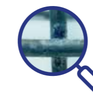
Auréoles blanches sur la soudure
