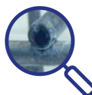
Noircissement sur l'extrémité du fil
