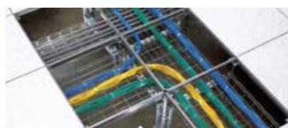
Les câbles VDI sont plutôt posés que tirés dans le chemin de câbles et il est de coutume d'utiliser quelques accessoires dédiés afin de respecter les rayons de courbure minimaux de ces câbles : Tableau ci-dessous
