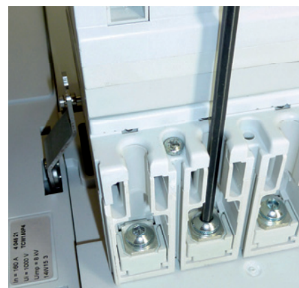
Serrer les connexions électriques amont et aval grâce aux huit (ou six) vis fournies avec la base (couple de serrage : 8N·m -> DPX 3 160 ; 10N·m -> DPX 3 250 ; 24N·m -> DPX 3 630).
