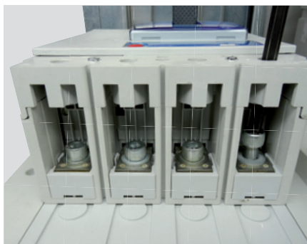
Serrer les connexions électriques amont et aval grâce aux huit vis fournies avec le disjoncteur. Appliquer un couple de serrage de 24 Nm.
